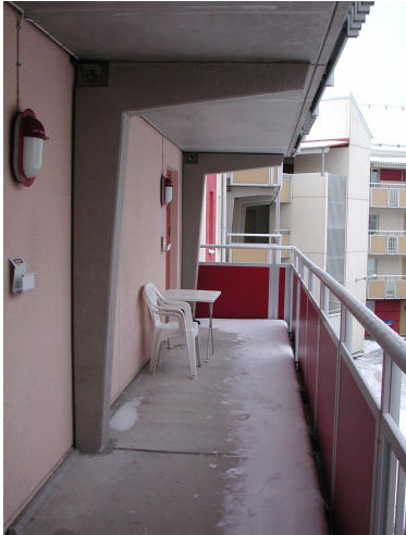
Loftgång, Kopparlunden 1, Västerås
